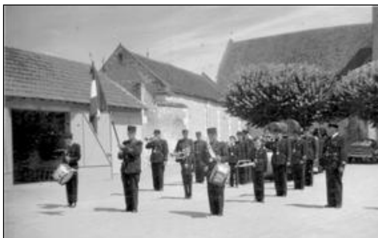
Rassemblement devant le nouveau local à incendie
